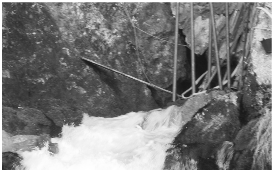
Noch die Sicherungsstützen entfernen, dann sieht alles wieder so aus wie früher. Höchstens mit einem etwas grosszügigeren Ausfluss...
